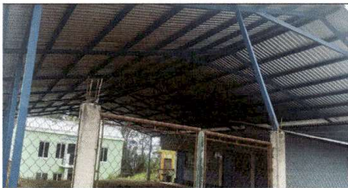
Foto 3: Se sustituyó la estructura de madera, por la estructura de metal, en el área de patio.
