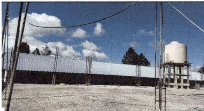
Foto 1: Se sustituyó lamina dteriorada, por lámina troquelada alum zinc calibre 26, en el área de patio.
