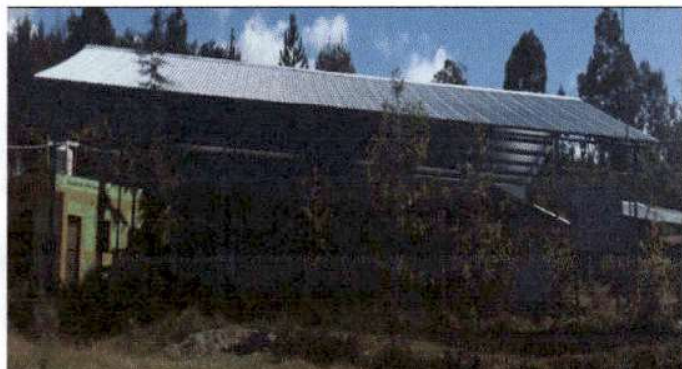
Foto 4: Se sustituyó estructura de madera, por estructura de metañ en el área de patio.
