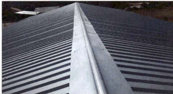
Foto 2: Se sustituyó capote de lámina, por capote de lámina troquelada, en el área de patio.
